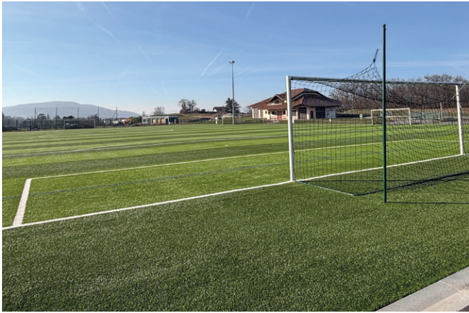
▲ Réfection du terrain de foot par une solution synthétique nouvelle génération composée en grande partie de liège, changement de l'éclairage et création d'une liaison PMR. Livraison en août 2024.
